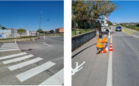
Sécurisation accès centre commercial Nord
