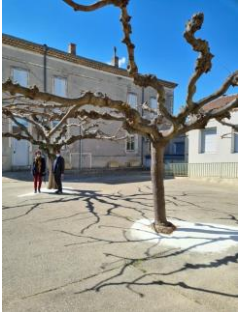
Réfection du revêtement autour des arbres de l'école publique
