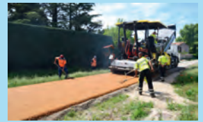
Voies douces enrobés drainants Lutte contre les îlots de chaleur
