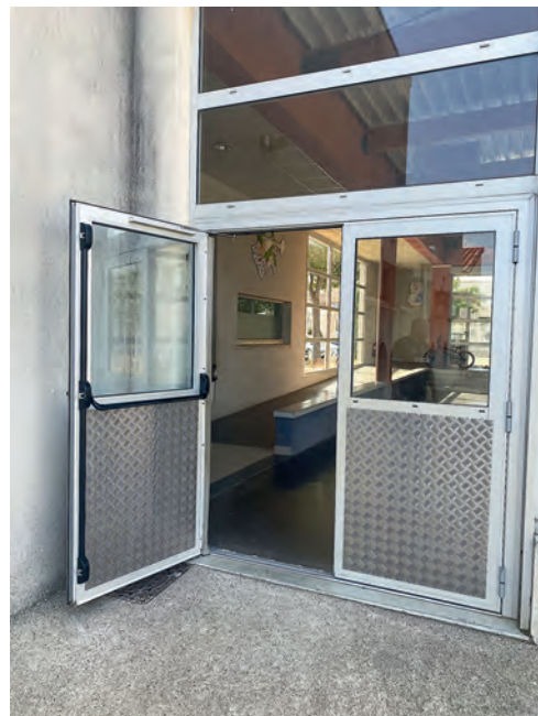
Sécurisation : pose de panneaux métalliques
