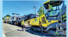
Retraitement des matériaux de chaussée à 100 %
